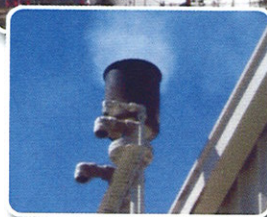
設置前： 可視オイルミスト飛散
