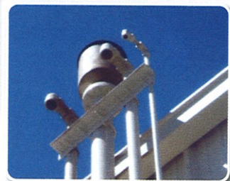
設置後：Solbergのオイルミストエリミネータによるクリーンで安全な排気
